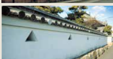
▲西光寺の鉄窓のある白壁
