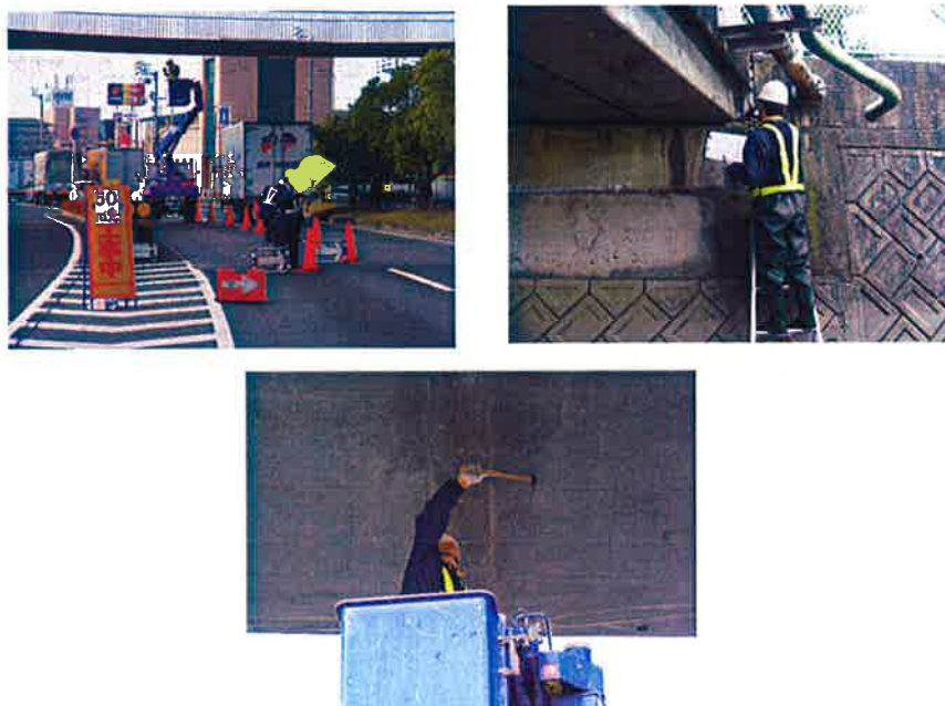
図 3.1 定期点検の様子
